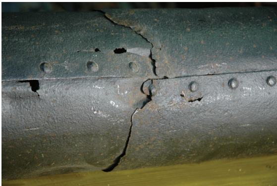
Fig. 3. Analisi dello stato di conservazione: particolare del camino.
